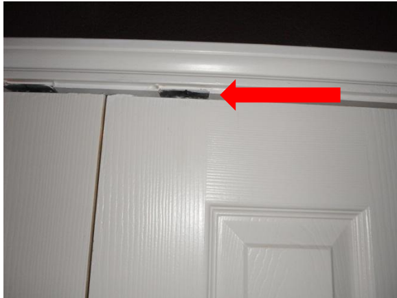
Media Room Door
